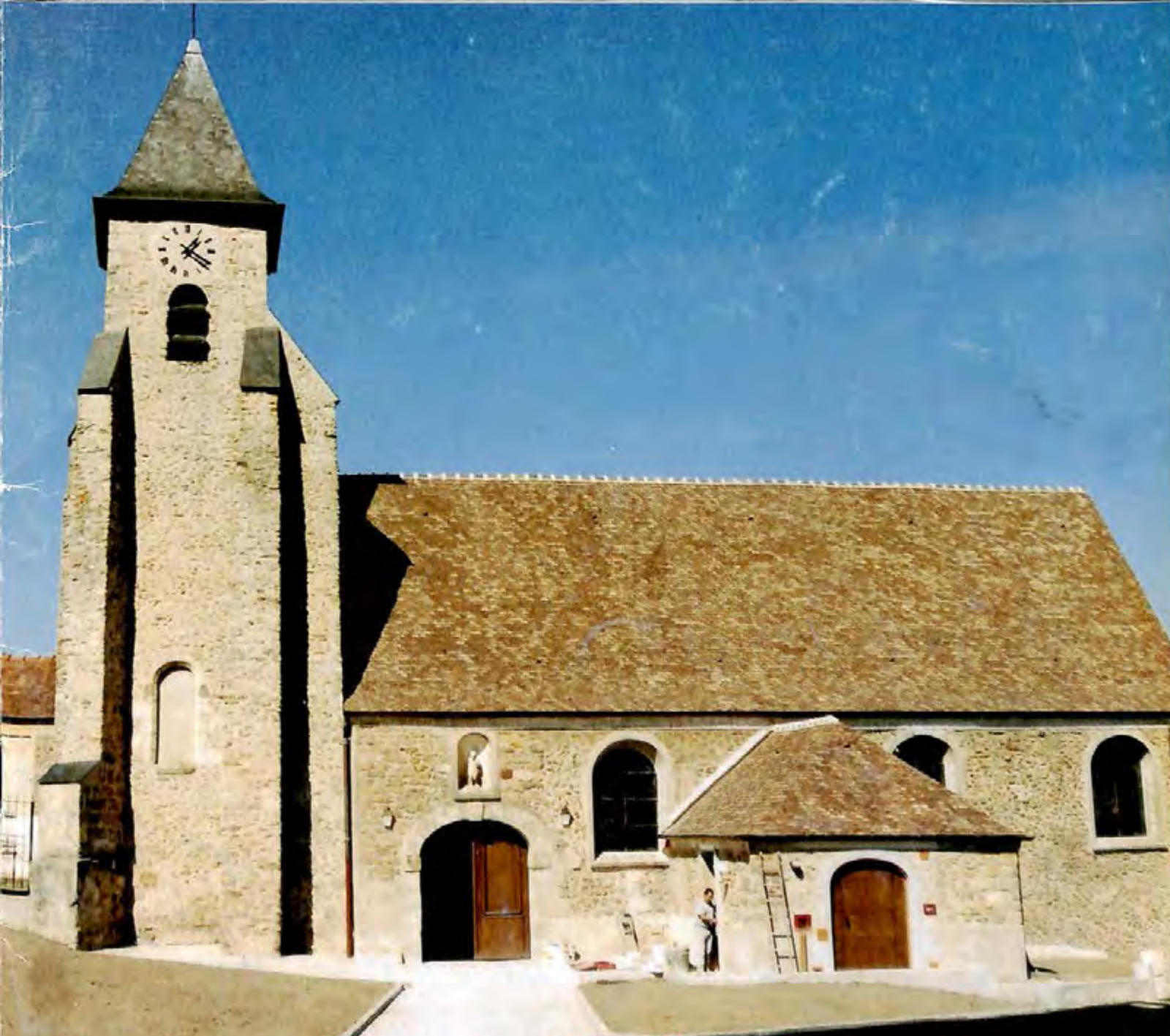
Restauration de l'église Saint Marcel
