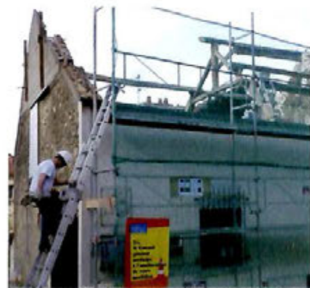
Travaux au Centre de Loisirs
